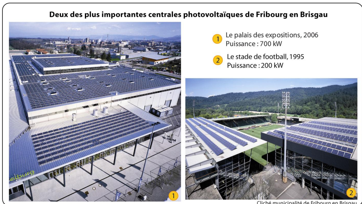
Photographie 3 : Deux centrales photovoltaïques de Fribourg en Brisgau.
