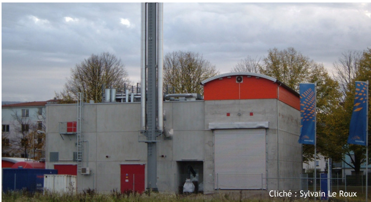
Photographie 20 : la chaufferie au bois équipée d'une cogénération, quartier Vauban (All.).
