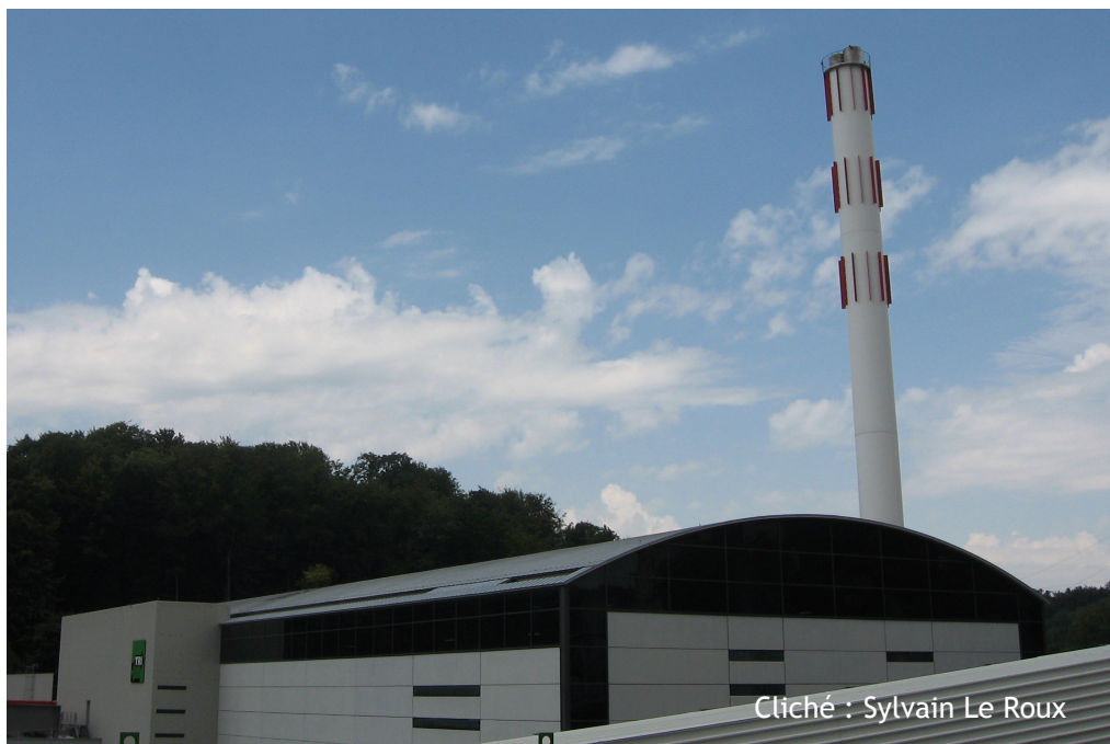
Photographie 7 : La centrale Energie-déchets TRIDEL à Lausanne.
