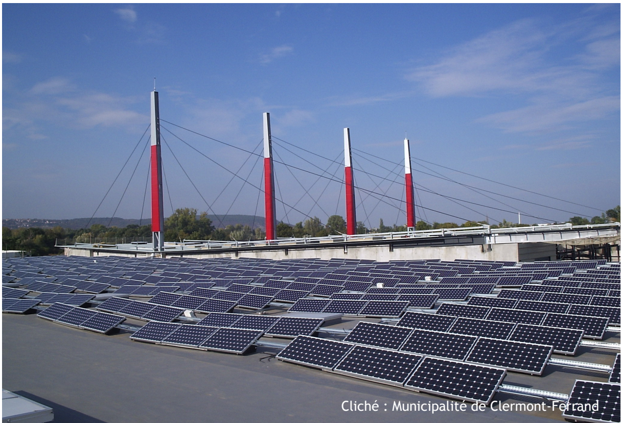
Photographie 9 : Les panneaux en surimposition de la centrale photovoltaïque de Champratel.
