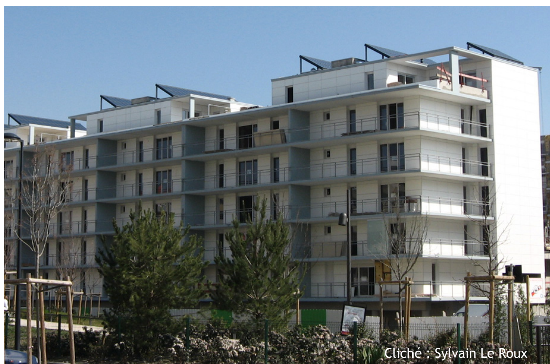
Photographie 12 : L'intégration du solaire thermique à Vigny-Musset.
