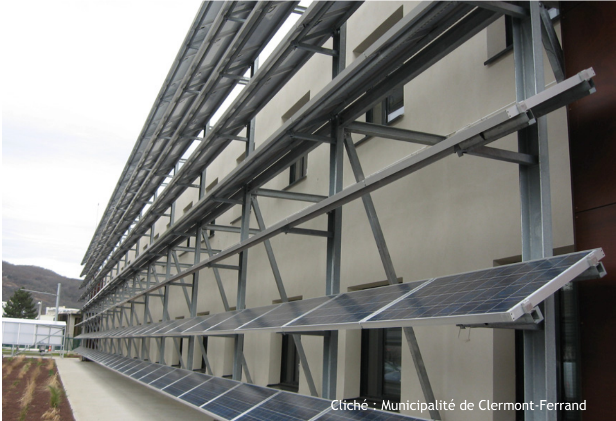
Photographie 8 : Les panneaux intégrés au bâti de la centrale de Champratel.
