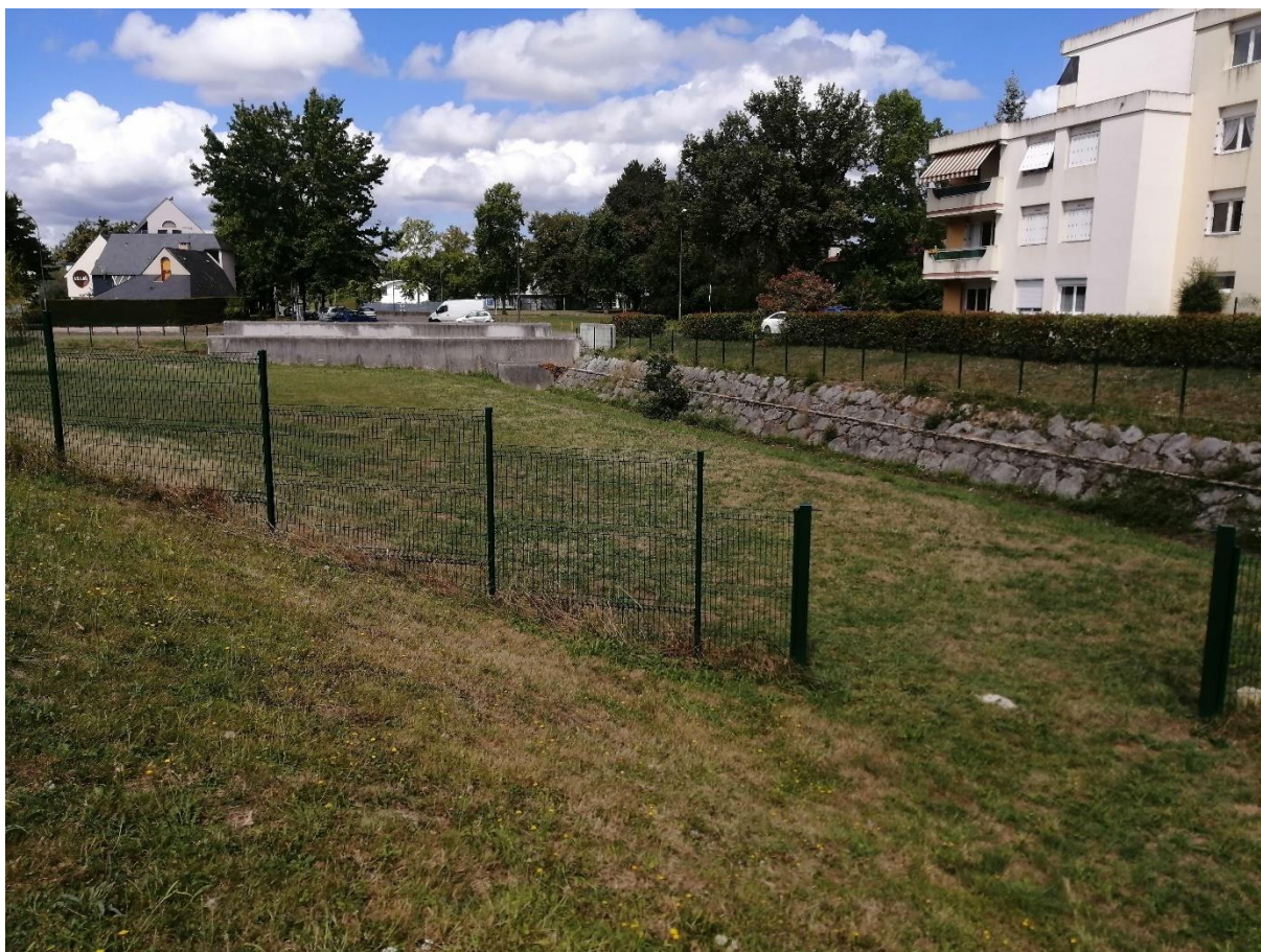
Figure 19 : Bassin d'orage dans un parc, clôture à fermer en cas de risque d'inondation de la zone, Pau
