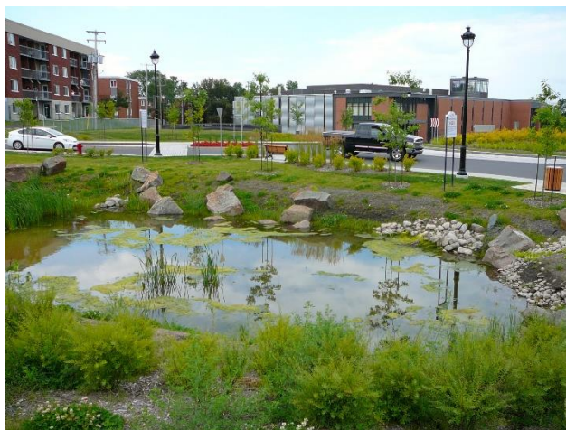
Figure 20 : Bassin en eau de Levis (Québec).
