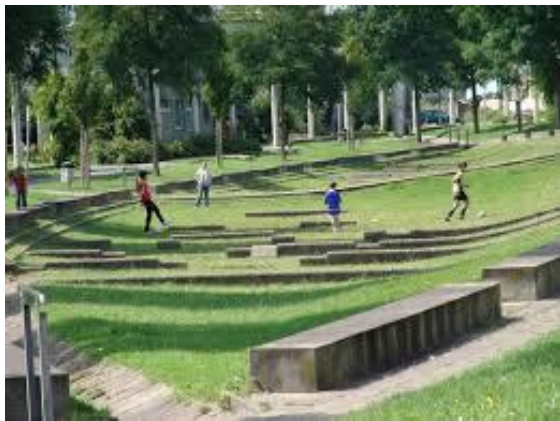
Figure 15 : Bassin sec aménagé en aire de jeu Source : confederationconstruction.be
