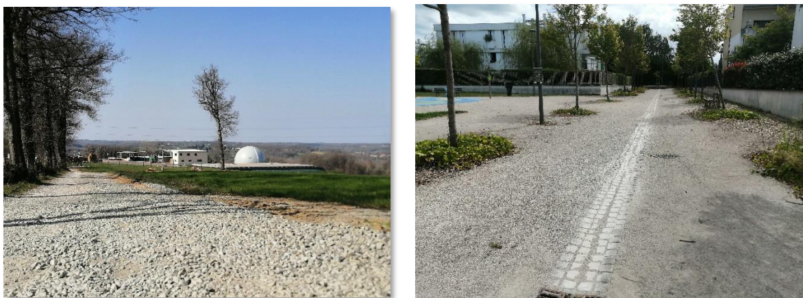
Figure 28 : Voirie en grave non traitée pour accéder à une unité de méthanisation et voirie engravillonnée d'accès à un quartier
