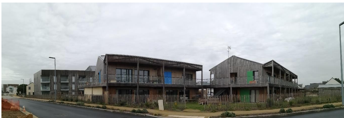
Figure 69 : Zone tampon créée par une double façade ventilée Source : https://www.energieplus-lesite.be
