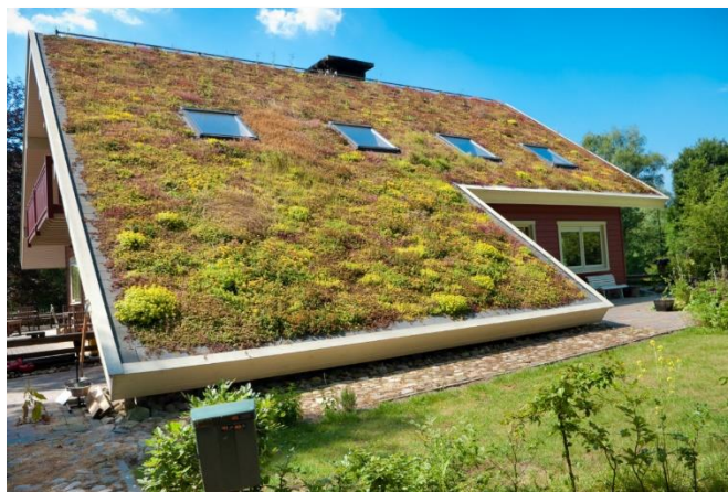
Figure 48 : Toiture végétalisée extensive. Source : toiture-couvreur.fr
