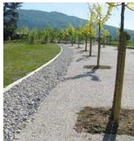
Figure 29 : Tranchée longeant une voie piétonne. Source: gesteau.fr
