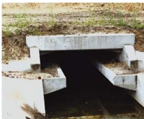
Figure 41 : Passage hydraulique. Source : trameverteetbleue.fr
