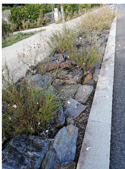
Figure 31 : Tranchée d'infiltration de l'écoquartier la Bottière-Chênaie, Nantes Source : Sylvain LE ROUX, ENCIS ENVIRONNEMENT
