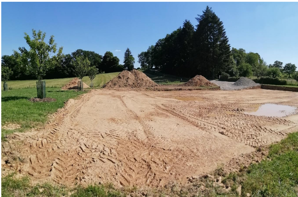
Figure 1 : Chantier de terrassement pour une voirie et un bâtiment
