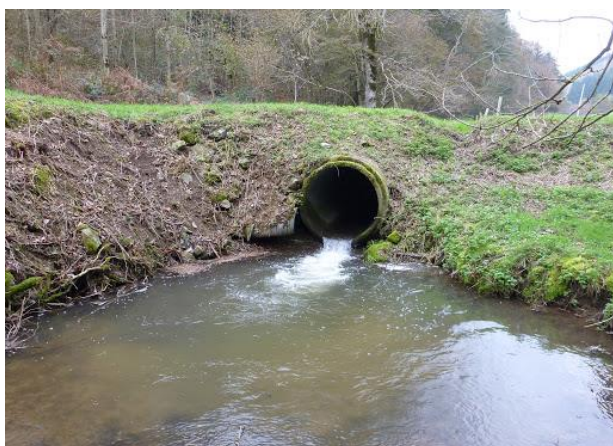
Figure 5 : Exemple d'une buse mal calée (à gauche) et d'une buse correctement installée (à droite)
