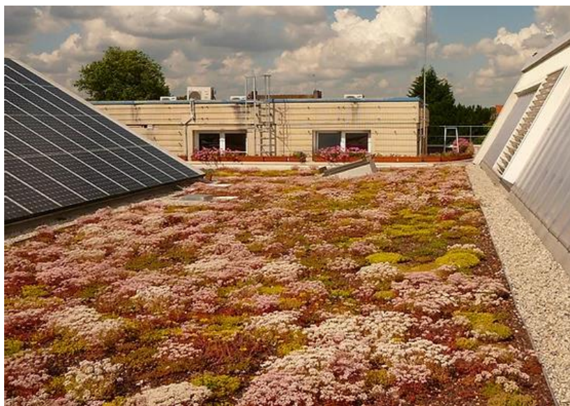
Figure 6 : Toiture stockante végétalisée Source : ADOPTA
