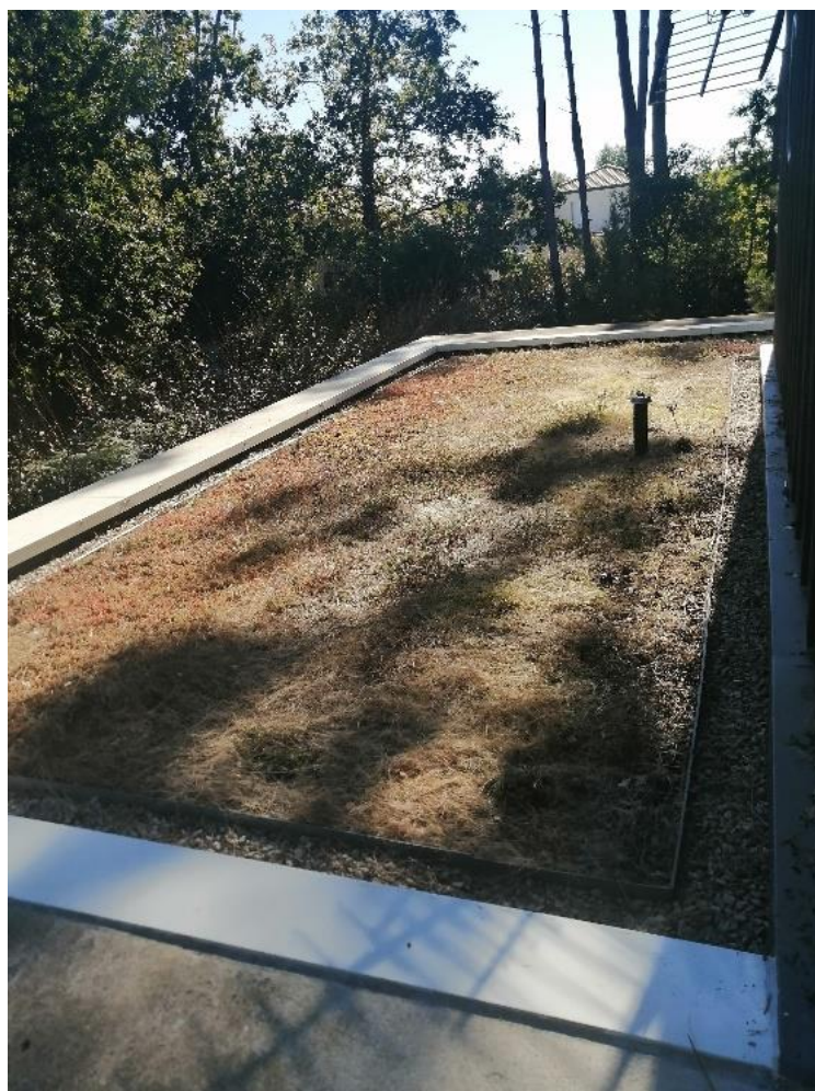
Figure 8 : Toiture stockante à végétation extensive d'une maison individuelle Source : Sylvain LE ROUX, ENCIS ENVIRONNEMENT
