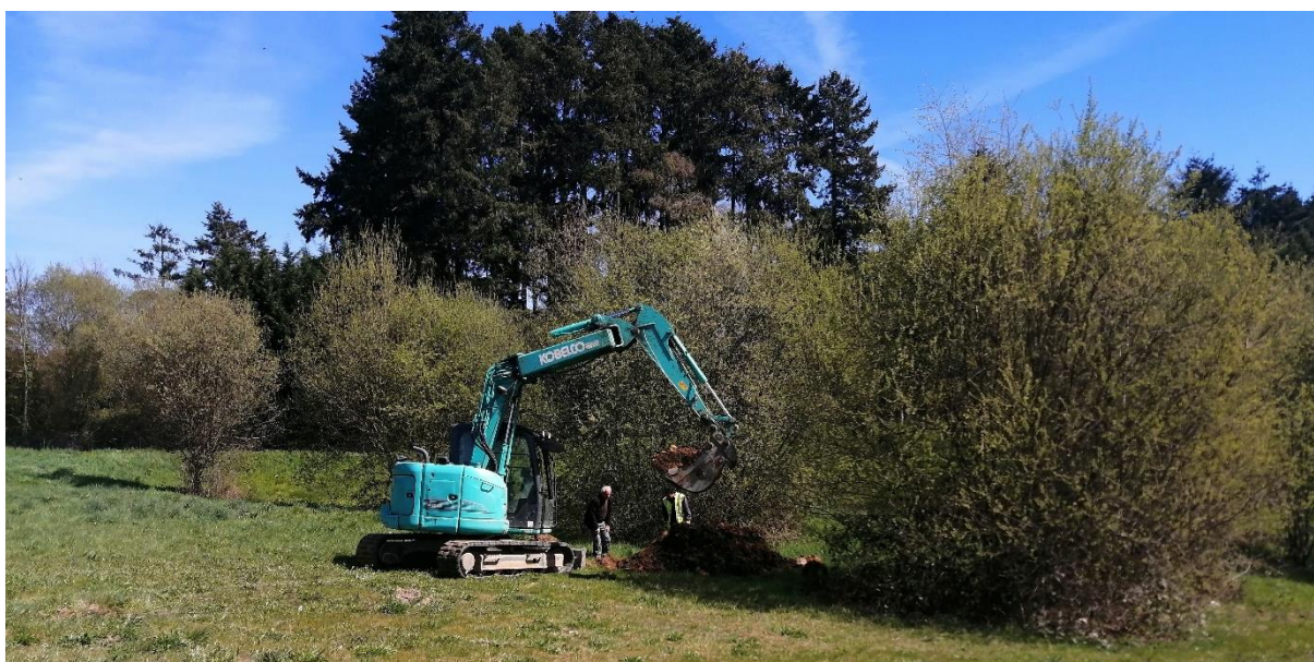
Figure 3 : Sondages géotechniques en vue d'étudier des fondations-pieux non impactantes
